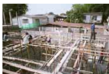
写真8 建設中の住宅
