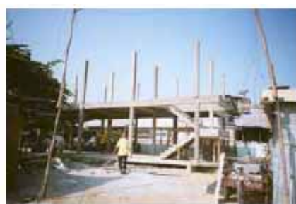
写真17 建設中のセンター
