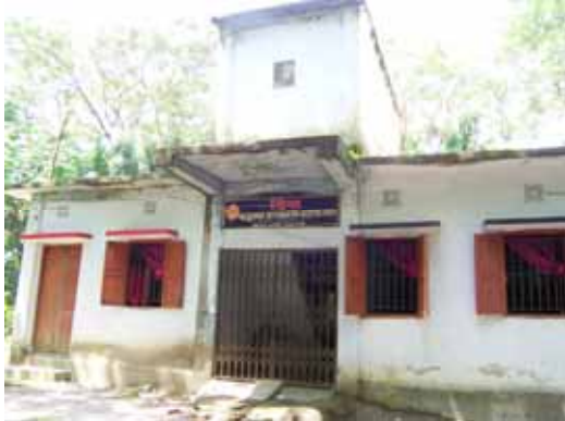
<写真 3 - 4> RIC オフィス：壁がコンクリートで屋根がトタンでできている。
